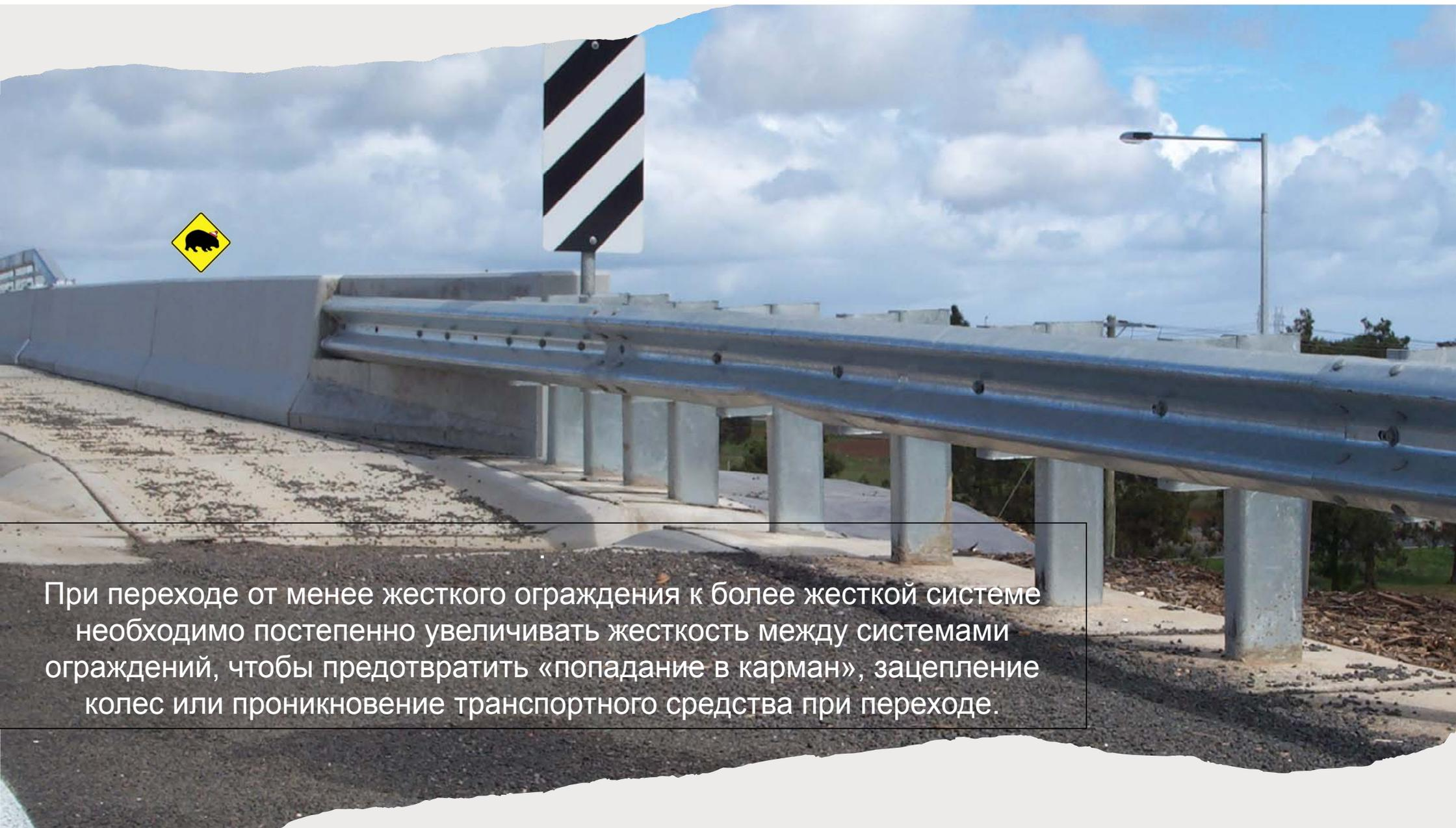
При переходе от менее жесткого ограждения к более жесткой системе необходимо постепенно увеличивать жесткость между системами ограждений, чтобы предотвратить «попадание в карман», зацепление колес или проникновение транспортного средства при переходе.
