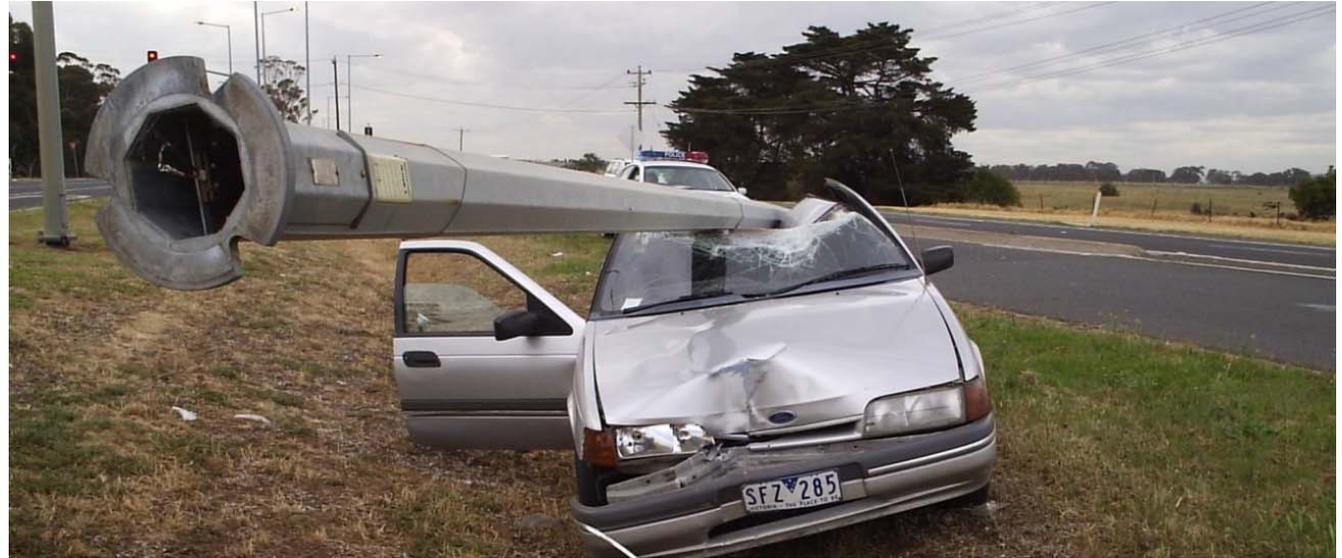
Ударобезопасные опоры освещения
