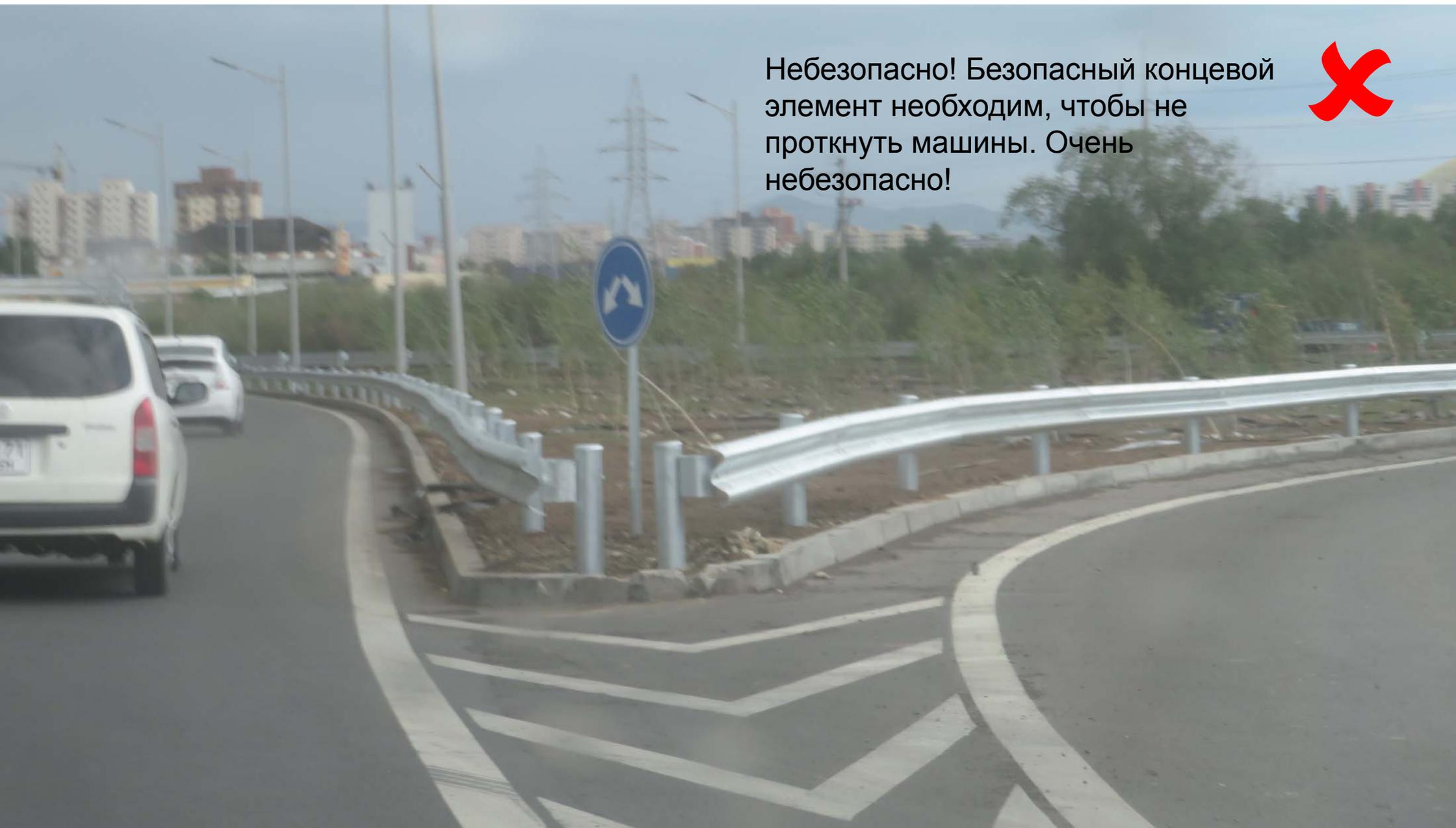
Наклонные концевые элементы опасны. В случае удара автомобиль может взлететь или перевернуться.
