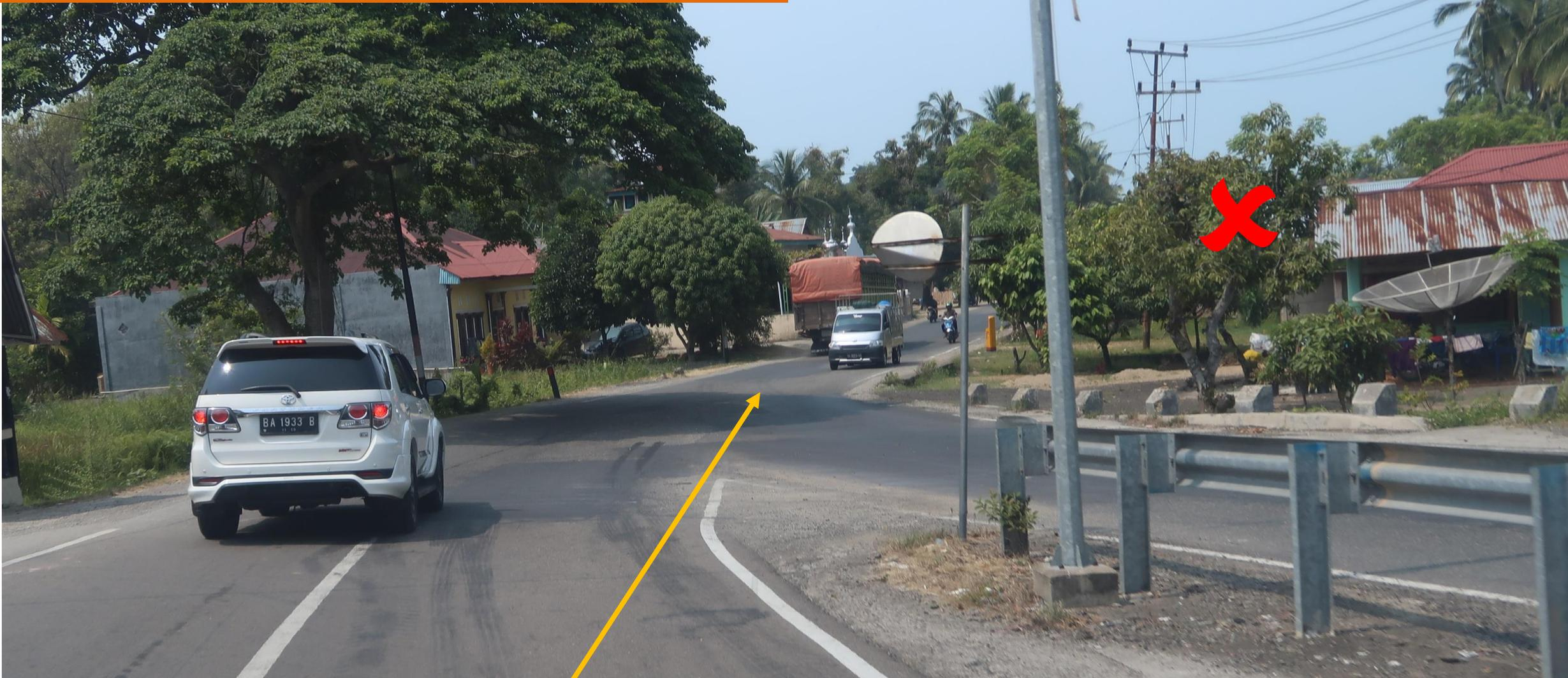
Там, где заканчивается участок с разделительной полосой, убрать одну полосу движения (крайняя правая полоса движения) задолго до окончания разделительной полосы. Свести движение обратно в одну полосу, используя знаки и линии, перед участком без разделительной полосы.
