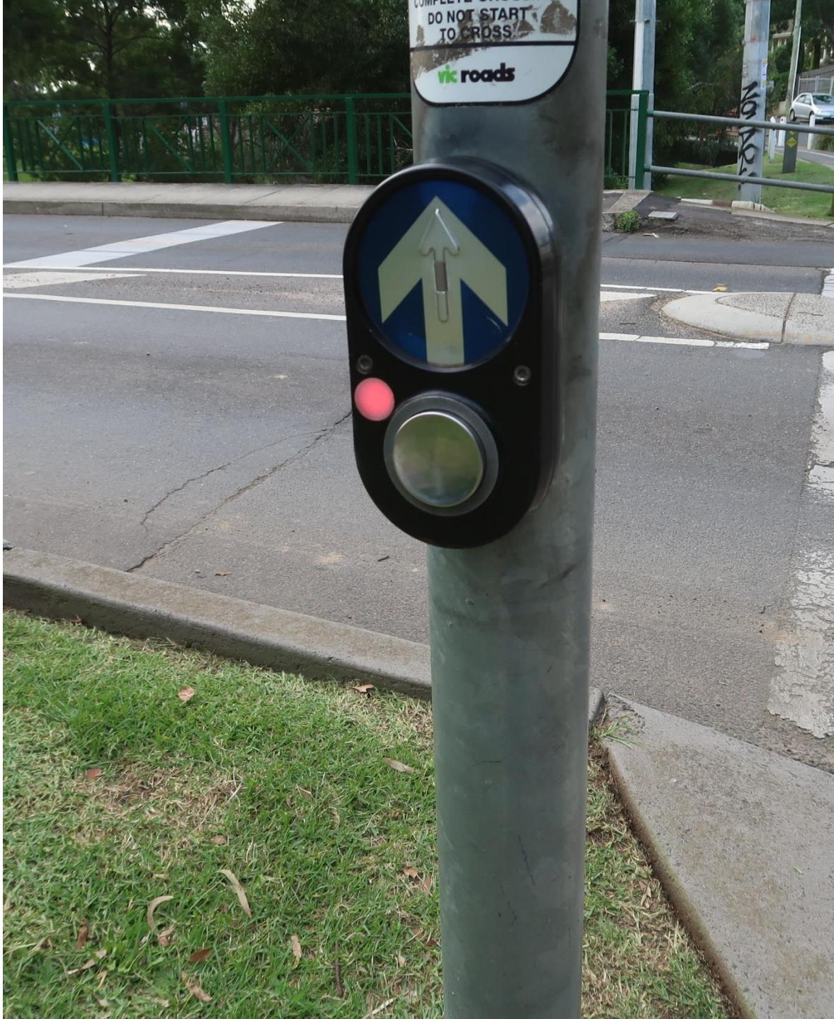
**Рисунок 13: Типичное расположение кнопок для пешеходов**
