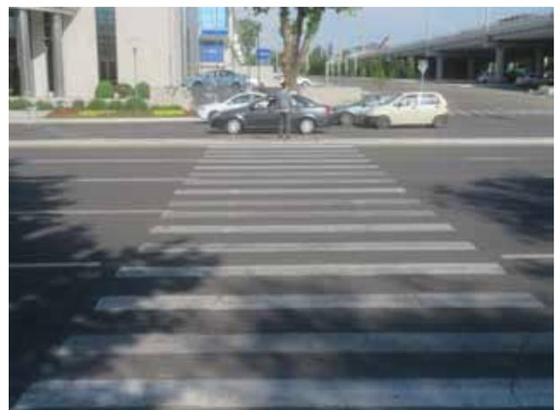
**Некоторые места слишком опасны для перехода типа «зебра».** В некоторых местах пешеходам будет безопаснее без перехода. Переходы «зебра» не следует использовать на скоростных дорогах или на широких дорогах с двумя или более полосами движения в каждом направлении.
