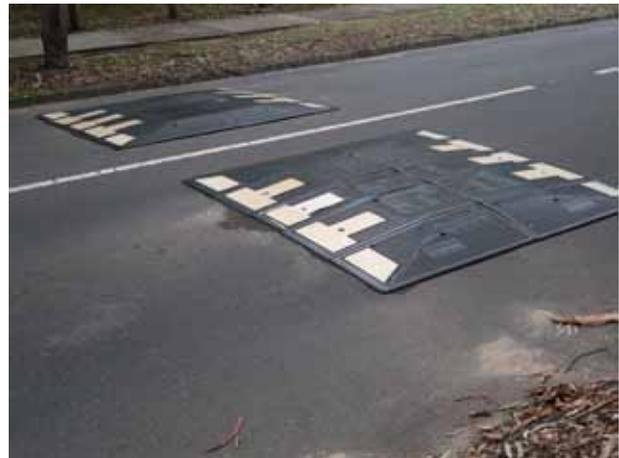
**Вертикальные устройства для снижения скорости.** Устройства вертикального смещения снижают скорость 85-го перцентиля примерно до 35 км/ч. Размещение перехода на «хампе» делает переход более заметным и позволяет пешеходам переходить дорогу на уровне пешеходной дорожки (над лужами) в точке с наименьшей скоростью движения транспортных средств. Было показано, что размещение перехода на «хампе» снижает вероятность столкновения с пешеходами на 73% (Приложение 2).
