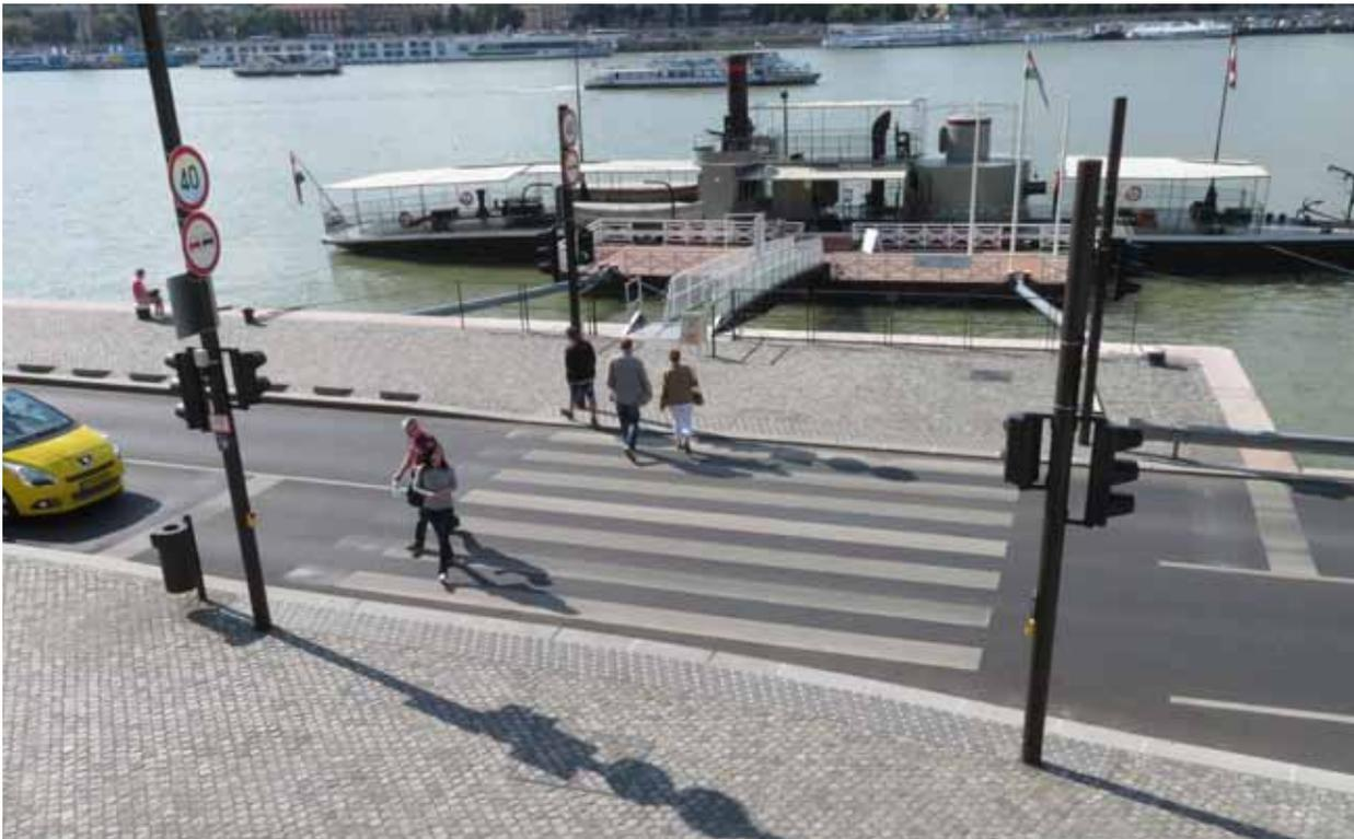
**Пешеходные сигналы.** Важнейшими компонентами пешеходных сигналов являются заметные сигнальные дисплеи (для водителей и пешеходов), четкая разметка линий (для определения зоны перехода), легкий доступ пешеходов (через пандусы) и освещение сверху. Достаточное время для перехода жизненно важно для безопасности пешеходов. Добавление пешеходных кнопок (создание УПС) предлагает пользователям более высокий уровень сервиса.
