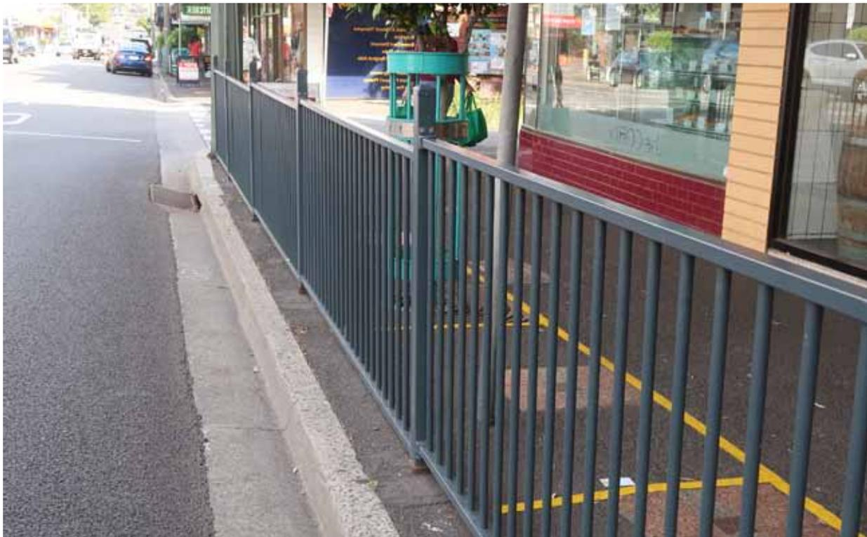
**Пешеходные ограждения.** Ограждение для пешеходов может быть полезным для направления пешеходов к безопасным переходам или для предотвращения их нечаянного вступления в высокоскоростной транспортный поток. Его конструкция не должна допускать лазания, но должна обеспечивать хороший обзор через вертикальные перекладины. Таким образом, увеличивается вероятность того, что маленький ребенок будет замечен водителями до того, как он выскочит на дорогу.
