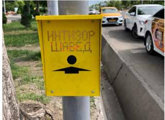
**Фотографии «после», на которых показаны недавно установленные пешеходные сигналы.** Сигналы, управляемые пешеходами, хорошо служат пешеходам. Пандусы и небольшой мост через водосток обеспечивают пешеходам легкий доступ к переходу, а кнопки позволяют им активировать сигнал перехода. ((Фотографии предоставлены Восточным альянсом за безопасный и устойчивый транспорт [EASST], Молодым поколением Таджикистана и Фондом безопасных дорог).
