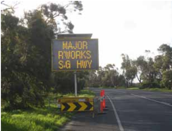
Пример ТПИ, установленного на прицепе, расположенном на обочине сельской автодороги с ограничением скорости до 100 км/час (движение по левой стороне)
