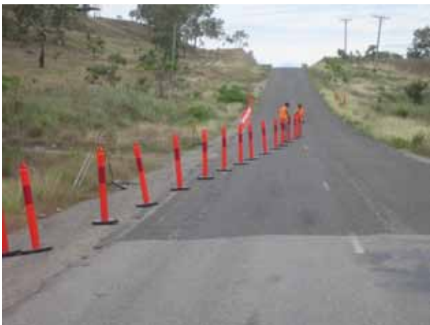
Конусы и переносные столбики для обозначения отгона лучше всего расположить с шагом 5 м.
