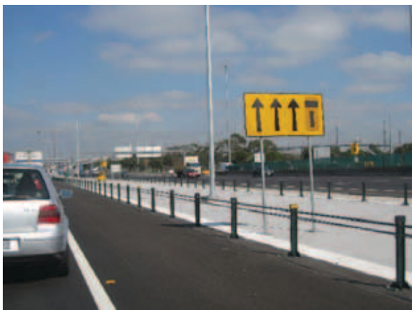
При проектировании системы тросовых ограждений всегда помните о том, что необходимо предусмотреть надлежащее расстояние между ограждением и опасным объектом для обеспечения прогиба ограждения. Гибкие ограждения могут прогибаться на два и более метра.
