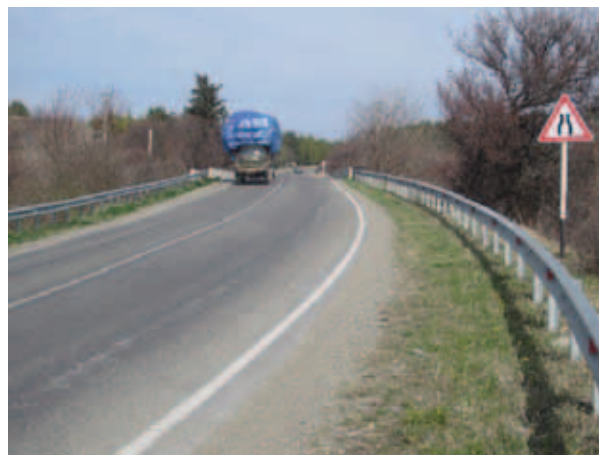
Полужесткие ограждения широко используются в течение десятилетий. Их прогиб при ударе может достигать одного метра. Поэтому они должны находиться на расстоянии не менее одного метра от тех опасных объектов, которые они ограждают, а также должны быть вынесены (минимум) на расстояние 4 м от дороги (если позволяет ее поперечный профиль), с тем, чтобы обеспечить безопасную остановку.
