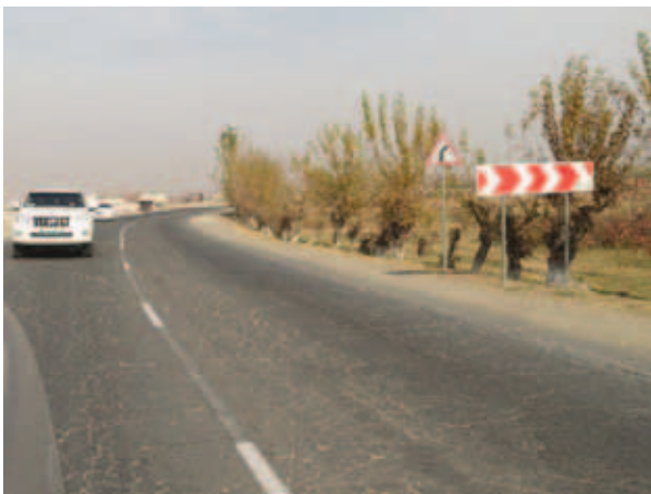
Данный указатель опасности является стандартным знаком, но он установлен в нестандартном месте. Внутренняя сторона кривой не самое лучшее место для таких указателей. Они должны устанавливаться на внешней стороне кривой.
