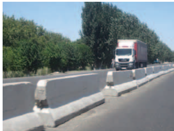
Бетонные ограждения в виде отдельных барьеров, подобные этому, могут помешать сделать неразрешенный поворот, но они опасны, особенно если удар придется по их незащищенной торцевой части.
