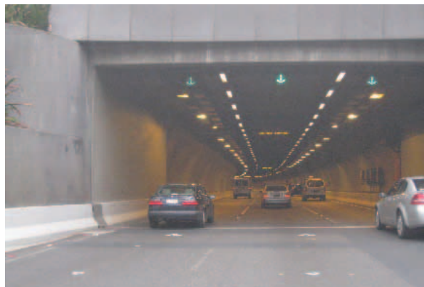
Жесткие ограждения (бетонные) не прогибаются и хорошо подходят в случаях, когда ширина дороги ограничена, и поперечные прогибы не допускаются.
