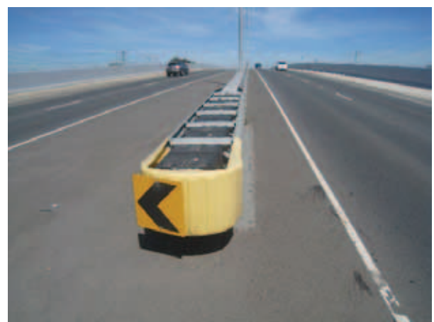
Энергопоглощающие элементы выпускаются различных типоразмеров для дорог разной ширины, а также для различных скоростных режимов.
