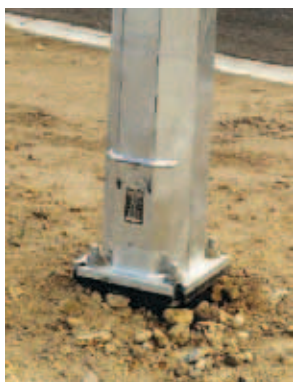
Энергопоглощающие опоры освещения подходят для низкоскоростных участков дорог (до 80 км/ч), где больше пешеходов и мест для парковки
