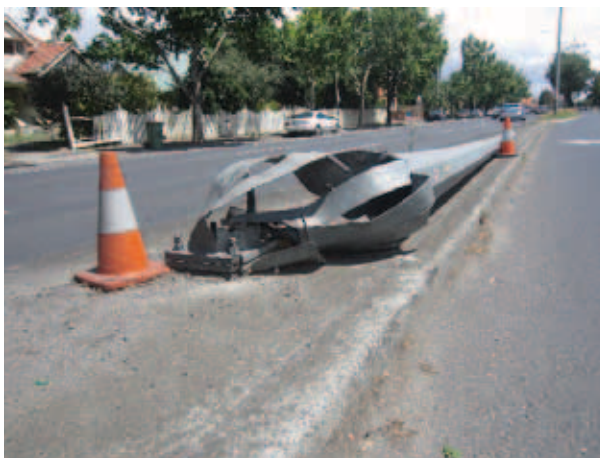
Энергопоглощающие опоры (такие, как показанная на фотографии опора после столкновения) помогают минимизировать травмы находящихся в транспортном средстве людей.
