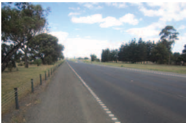
Рельефные краевые линии предупреждают уставших или отвлекшихся водителей о том, что они съезжают с дороги.
