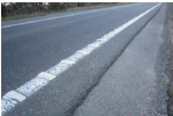
Было доказано, что рельефные краевые линии уменьшают количество аварий, связанных со съездом с дороги. Их лучше использовать в сочетании с укрепленными обочинами.
