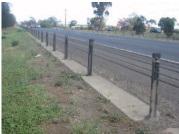
Гибкие ограждения (тросовые ограждения) являются проверенным и безопасным типом ограждений. При ударе они могут прогибаться на 2 метра (или более).
