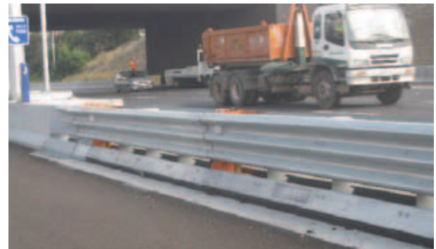
Существует несколько продуктов для закрытия разрывов разделительной полосы, которые обеспечивают надлежащий уровень удерживающей способности, и в то же время обеспечивают быстрый доступ соответствующих служб в случае аварийной ситуации.
