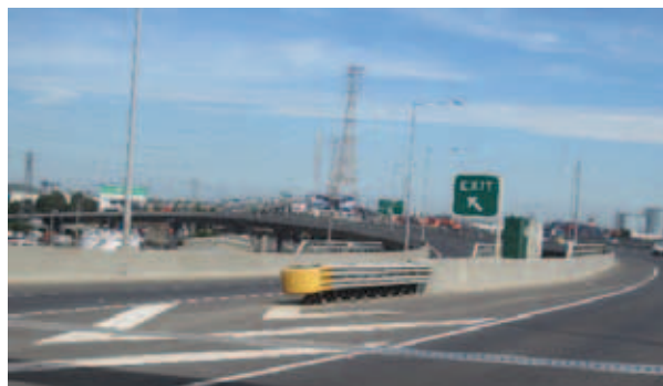
Демпферы ударных нагрузок хорошо подходят для защиты концов жестких ограждений на участках со стесненным пространством и интенсивным движением.
