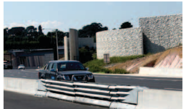
Эти устройства могут открываться уполномоченным лицом с помощью лебедки, и транспортные средства могут безопасно переезжать с одной проезжей части на другую в случае чрезвычайной ситуации. В остальное время они должны оставаться надежно закрытыми.
