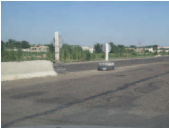
Старые покрышки или аналогичные неиспытанные и не одобренные средства не должны использоваться для защиты конечных и начальных участков жестких или полужестких ограждений.
