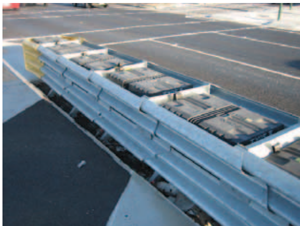
Некоторые энергопоглощающие элементы имеют энергопоглощающие ячейки внутри металлического кожуха для поглощения большей части энергии удара. В более дешевых моделях используются альтернативные системы.
