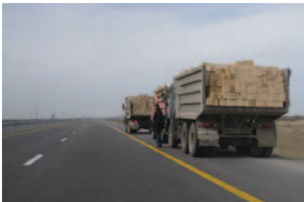
Укрепленные обочины также обеспечивают место для остановки транспортных средств в чрезвычайных ситуациях (чтобы проверить груз, или для оказания медицинской помощи).
