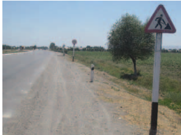
Уклон этого бокового откоса составляет приблизительно 1V:3H. Считается, что такой уклон не позволяет восстановить управление, и он не должен учитываться, как часть свободной зоны. Свободная придорожная зона здесь включает обочину, часть бровки перед боковым откосом и часть поля за откосом.
