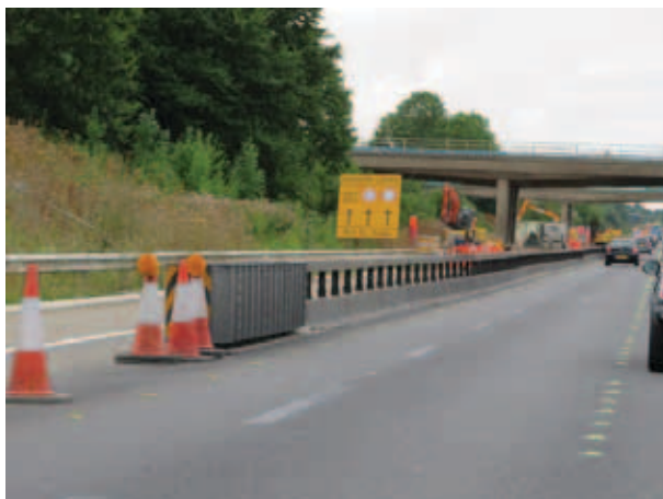
Некоторые энергопоглощающие элементы предназначены для использования в узких местах на участках дорожных работ.
