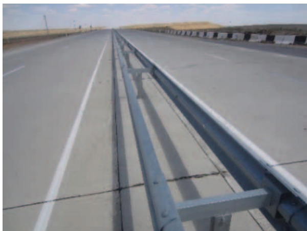
Полужесткие (барьерные) ограждения являются, пожалуй, наиболее распространенным типом ограждений вдоль автодорог ЦАРЭС. При ударе они обычно прогибаются на расстояние до 1 метра.
