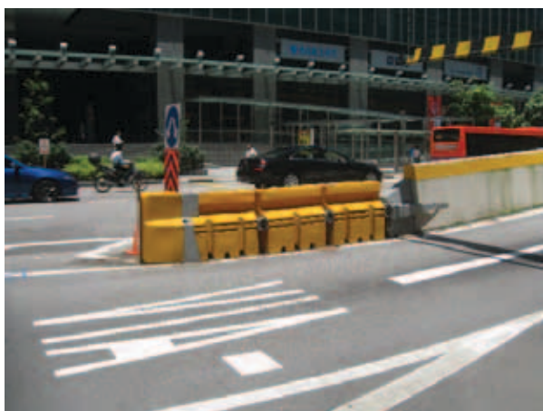
Имеется несколько типов энергопоглощающих элементов, которые одобрены для установки перед временным жестким ограждением на участках производства работ.
