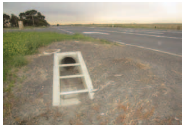
Откосные стенки 1-го типа, проходимые для АТС, подходят для ограждения выходов труб, направление которых параллельно дороге.
