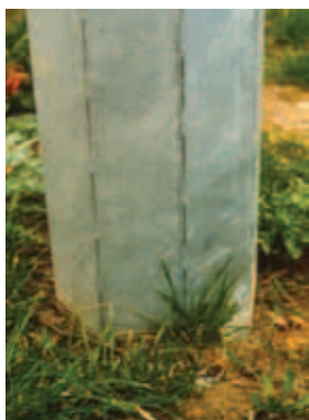
Энергопоглощающие опоры освещения подходят для низкоскоростных участков дорог (до 80 км/ч), где больше пешеходов и мест для парковки
