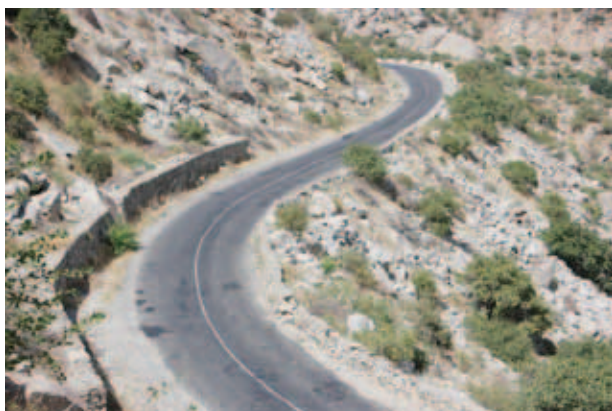
Автомагистраль – двухполосная автодорога, с движением в двух направлениях, проходящая по гористой местности. Она не имеет кривых малого радиуса, однако характеризуется многочисленными опасными придорожными препятствиями вдоль трассы.
