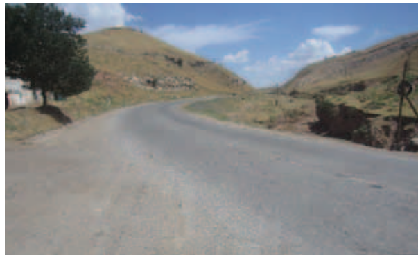
Скорость движения одиночных автомобилей составляет около 80 км/ч. Интенсивность движения составляет почти 4 000 АТС в сутки (в обоих направлениях). На автомагистрали отсутствует обозначение кромок дороги. Многие ДТП с участием одного АТС происходят в ночное время.
