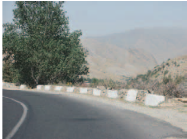
Транспортное средство, потерявшее управление, обычно проходит большее расстояние при съезде с дороги на внешней стороне кривой, такой как на фотографии. На рисунке 2 приведены корректировочные коэффициенты для свободных придорожных зон на криволинейных участках.
