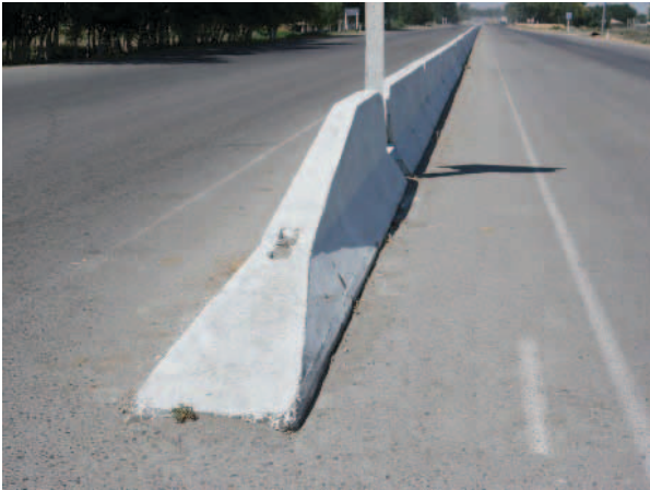
Концевые элементы с понижением не должны использоваться на начальных участках ограждений на дорогах с высокой скоростью движения, так как при наезде они обычно подбрасывают транспортное средство.
